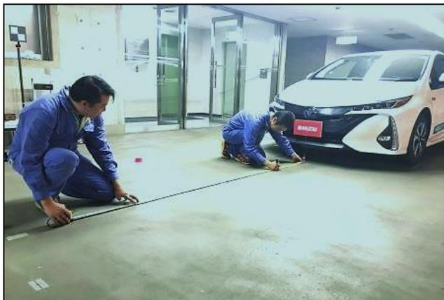
ターゲットを置く位置を出すために、中心線、直交線を引く作業として、**2~3人**作業で、**約10分**掛かります。
